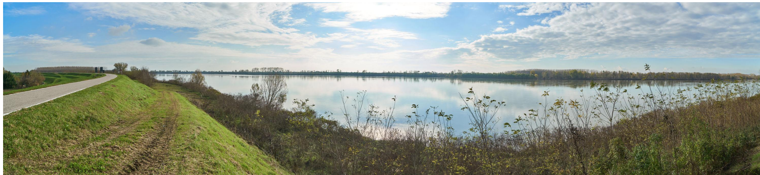
Punto di ripresa n°14 - viste dell'area di intervento del Gruppo n°3, dall'argine maestro del Po, in sponda sinistra. La foto mostra la struttura arginale con scarpata a vegetazione prativa ed una discesa carrabile; la fascia tra l'argine ed il fiume è ricca di vegetazione ripariale. Sulla riva opposta, dove è situata un'altra parte dell'intervento del Gruppo n°3, si notano zone golenali con coltivazioni di pioppeti e fasce alberate spontanee.
